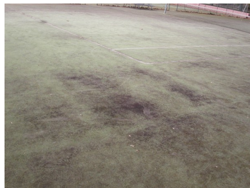
Terrain compacté et envahi par la mousse
