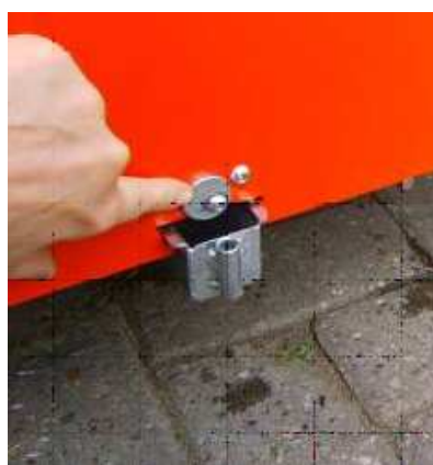
Photo 9 Verrouillage de la gouttière
